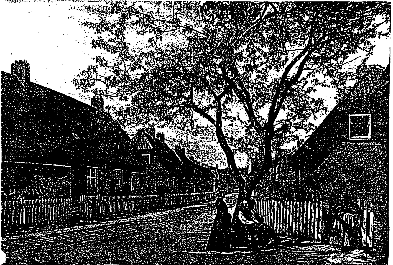
Source: Hermann Hecker Der Kruppsche Kleinwohnungsbau (Wiesbaden: 1917) Fig. #46
