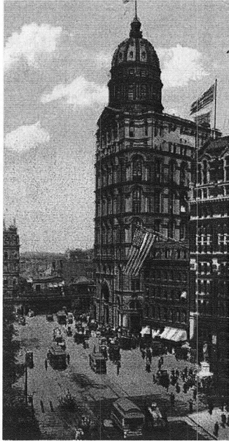
Figure 8. The World Building (1890) Courtesy of MIT Press
