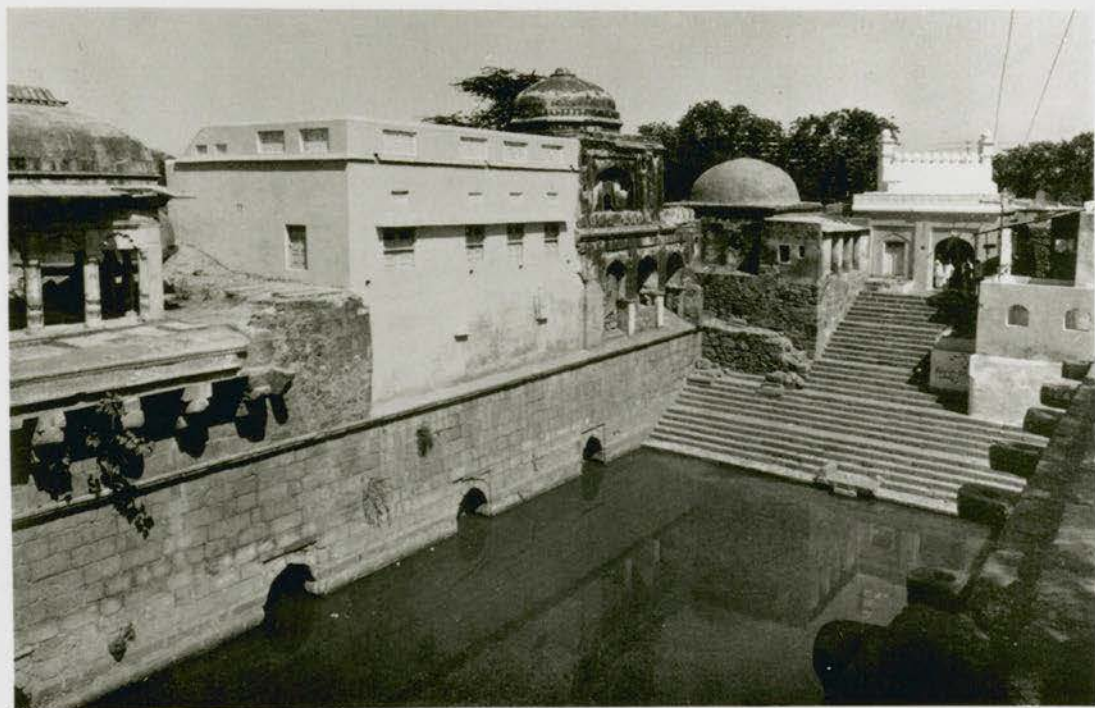
b W.19 同上 内部北側と西側
